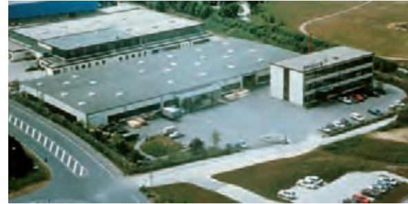
MIGUA Unternehmenszentrale in Wülfrath
